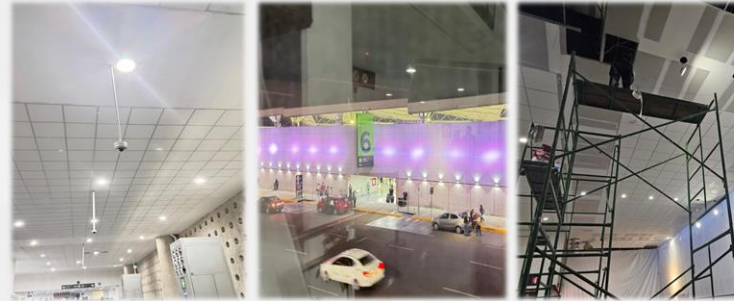
Sustitución de plafones y piezas de luminaria
