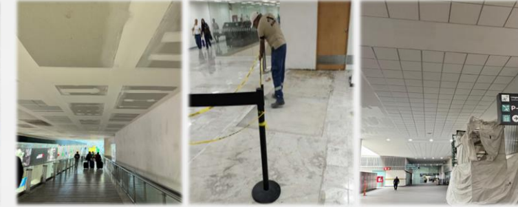
Pintado de columnas y reparación de pisos
